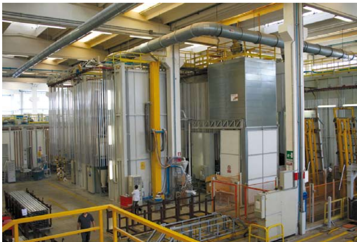
6 - Panoramica dell'impianto verticale per la verniciatura delle barre di 7 metri.
